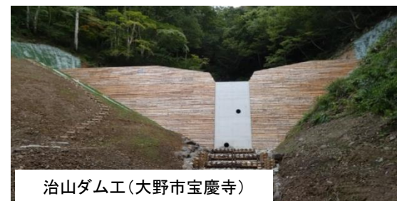
治山事業(治山ダム工)施行事例
