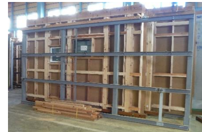
パネル工法での利用
