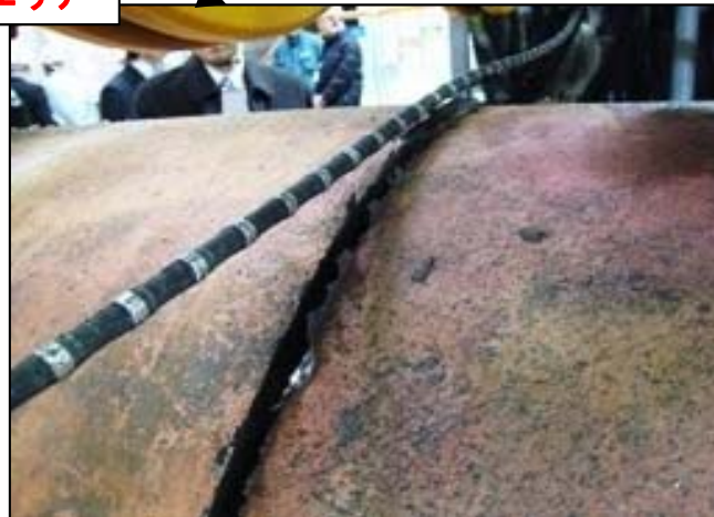
機械切断工法による切断実証
