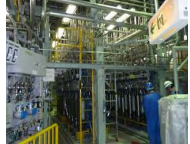
制御棒駆動ユニット等の解体
