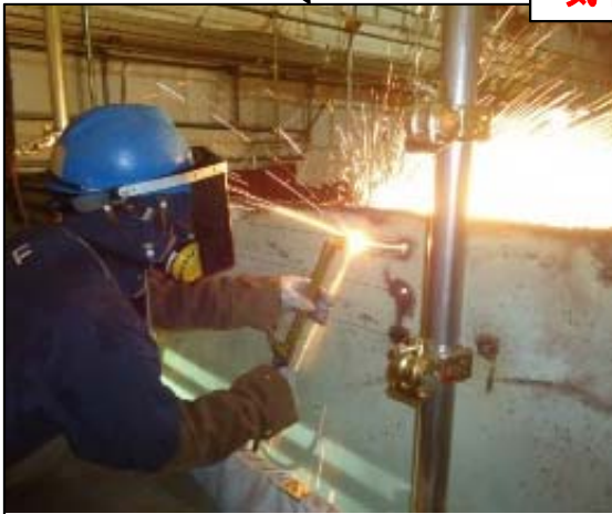
熱的切断工法による切断実証
