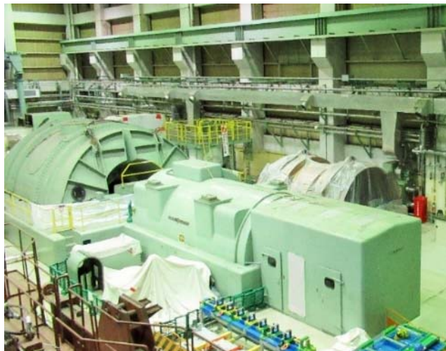
タービン・発電機等の解体
