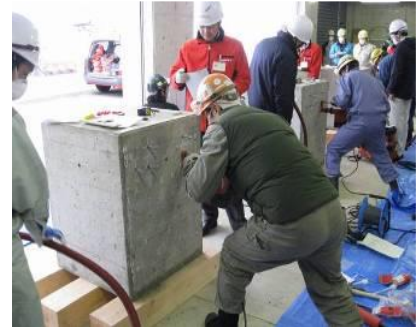
保守技能向上のための研修
